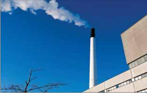
La cal viva es utilizada para disminuir los valores de emisión durante la depuración de los gases de escape. La cal viva se utiliza para purificar los ácidos, en particular los gases no persistentes ( $\text{SO}_2$ ) y  $\text{HCl}$ . La cal viva es utilizada para la eliminación tecnológica del mercurio también.
