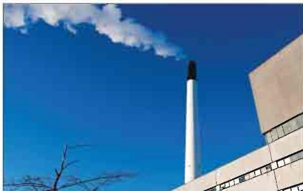
يستخدم الكلس أثناء تنقية غازات المدخن للحد من الانبعاثات. الكلس؛ يستخدم من أجل تنقية الغازات الحمضية وخاصة من الغازات المتطرفة ( $\text{SO}_2$ ) و ( $\text{HCl}$ ). وفي نفس الوقت يتم الإستفادة من التكنولوجيا القائمة على الكلس أيضا لاستخراج الزئبق.
